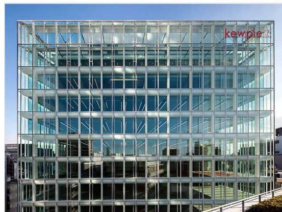
2重ガラスが覆う(ダブルスキン)外観
