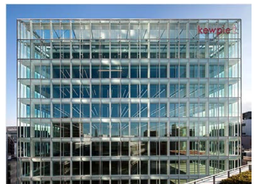
2重ガラスが覆う(ダブルスキン)外観
