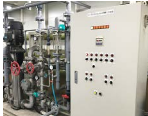
逆浸透膜(RO)ろ過装置
