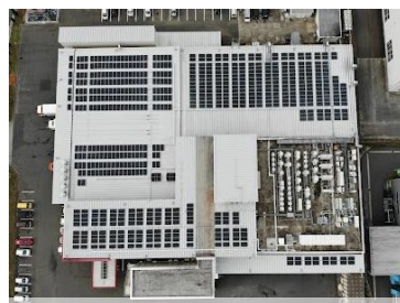
キタカミデリカ屋上に設置した太陽光パネル
