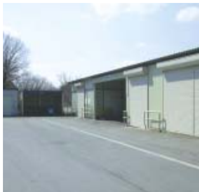
廃棄物の一次保管・処理場(階上工場)
